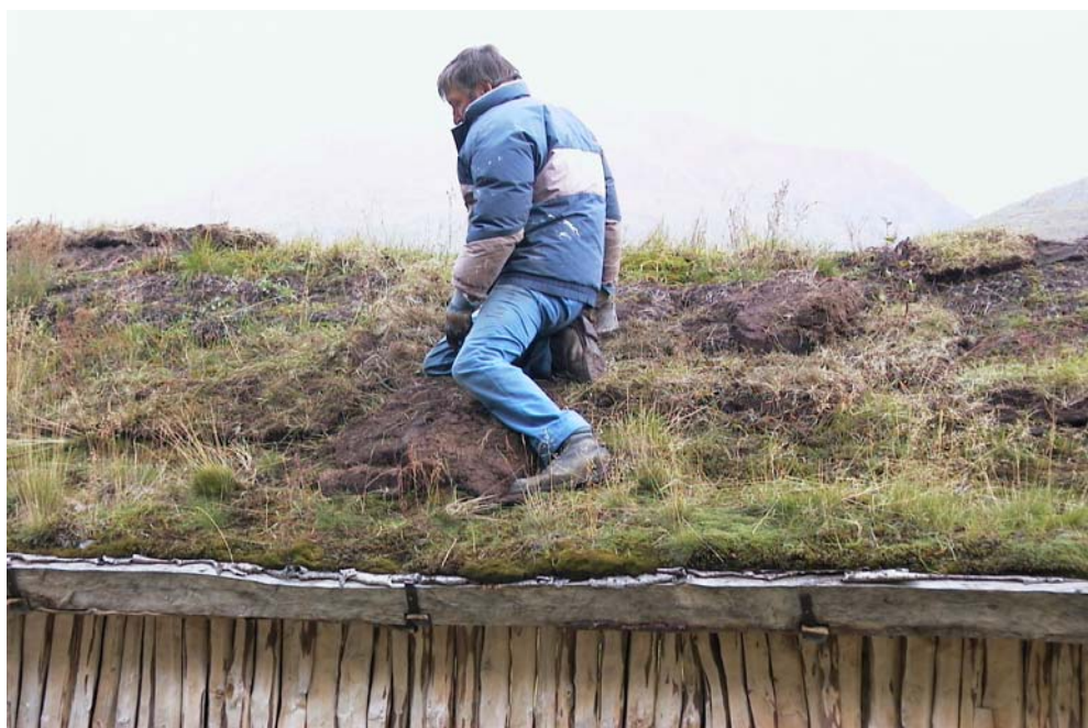
Restaurering av tak på Holmenes. Foto: Nord-Troms Museum
