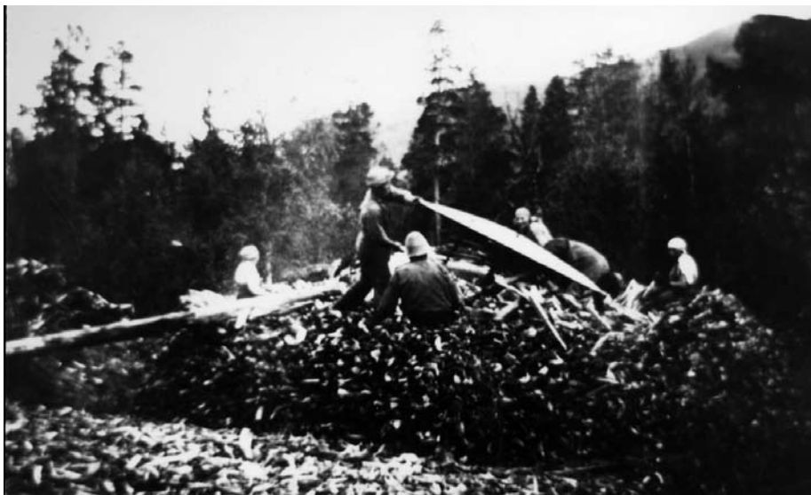
Både store og små, unge og gamle, var med på stablinga av tjæremila. Bildet er fra Marjastilla. Foto © Nord-Troms Museum
